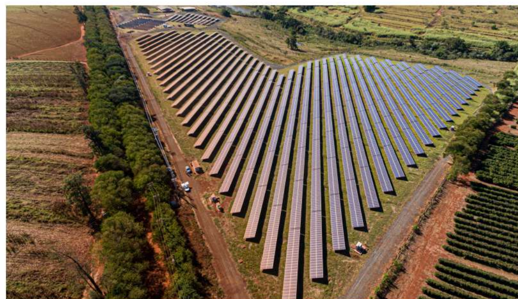
Usina fotovoltaica de P&D da BYD Brasil
