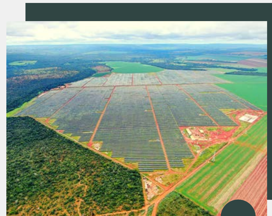
Usina solar com módulos fotovoltaicos BYD em Paracatu (MG)
